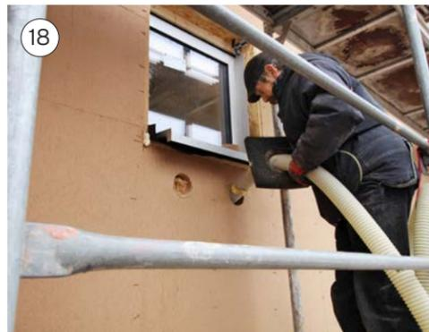
**18** **Wärmeschutz** Wandaufbau und eingblasene Dämmung sorgen für Best-Werte. Die berechneten Heizkosten werden um 50% unterschritten.
