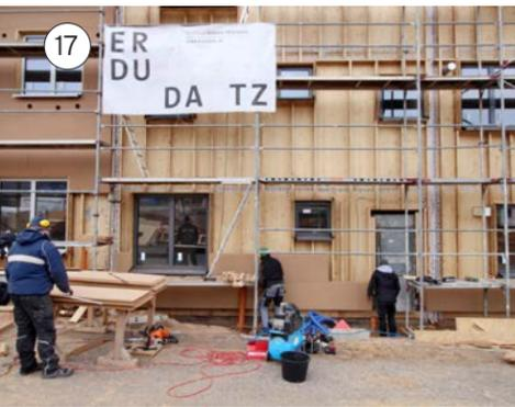
**17** **Wandaufbau** 12 cm Wand, 20 cm ausgeflockt, 6 cm Holzfaserplatte, hinterlüftete Lärchenfassade.
