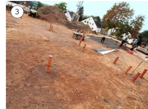
**3 Abwasser** Unter der Bodenplatte verlaufen die Rohre für das Abwasser. Die müssen zentimetergenau passen.
